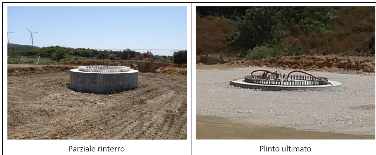
Nella fondazione verranno alloggiati anche le tubazioni in pvc corrugato per i cavidotti e le corde di rame per i collegamenti della messa terra. Alla fine delle lavorazioni i basamenti dovranno risultare totalmente interrati e l'unica parte che dovrà emergere, per circa 13 cm, sarà il colletto in calcestruzzo che ingloba la ghiera superiore, alla quale andrà fissato il primo elemento tubolare della torre.
