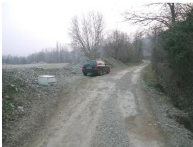
Foto n.2: vista sul tratto di massimo scavo previsto a progetto; sulla sinistra il recente grosso cumulo di inerti
