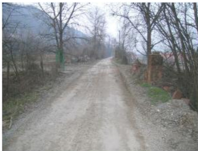
Foto n.1: vista sul tratto iniziale da adeguare
