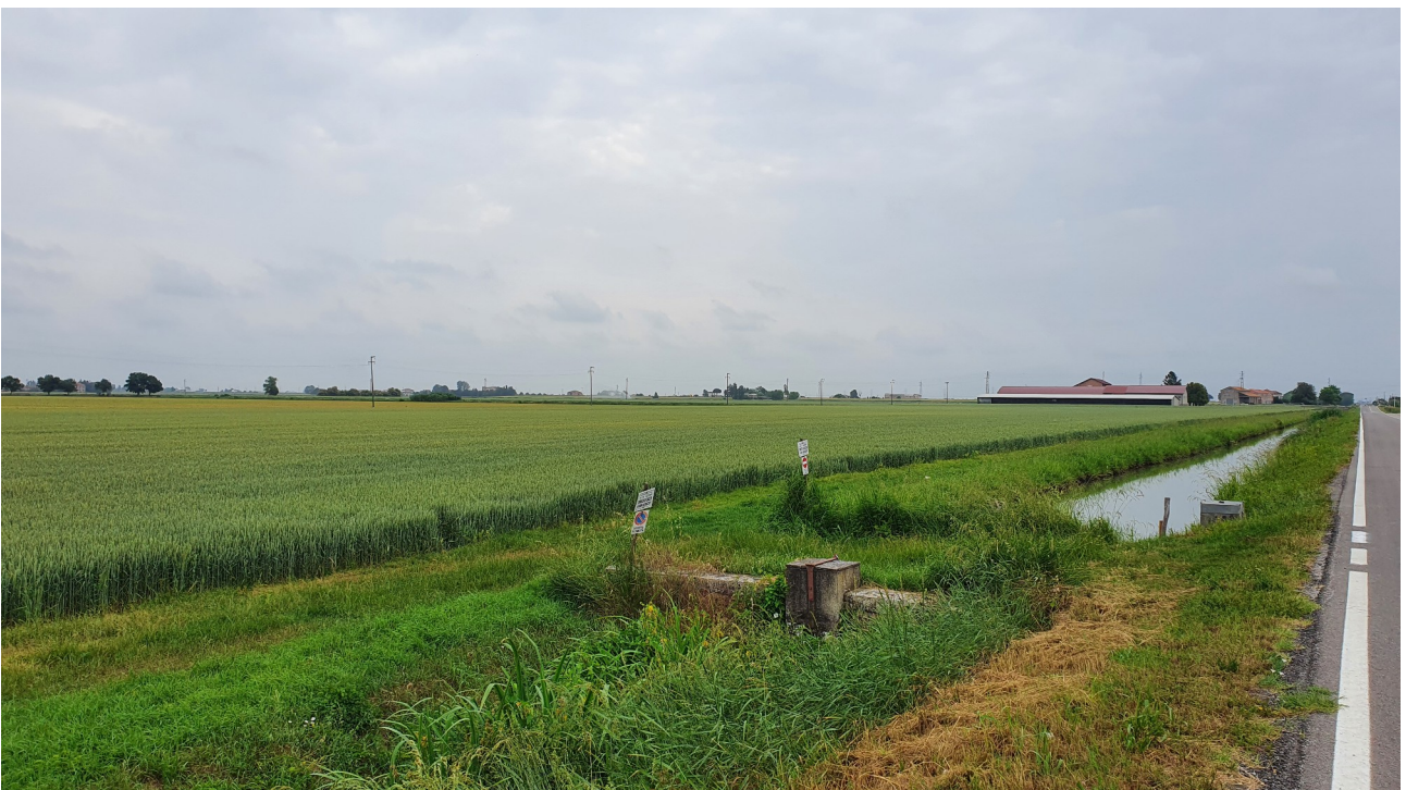
Figura 9: Altra vista del campo fotovoltaico sud
