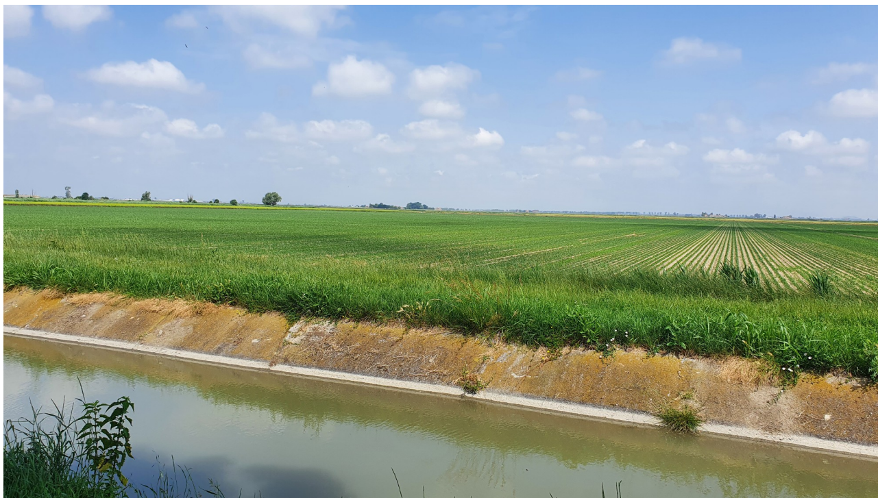
Figura 10: Vista del campo fotovoltaico Nord
