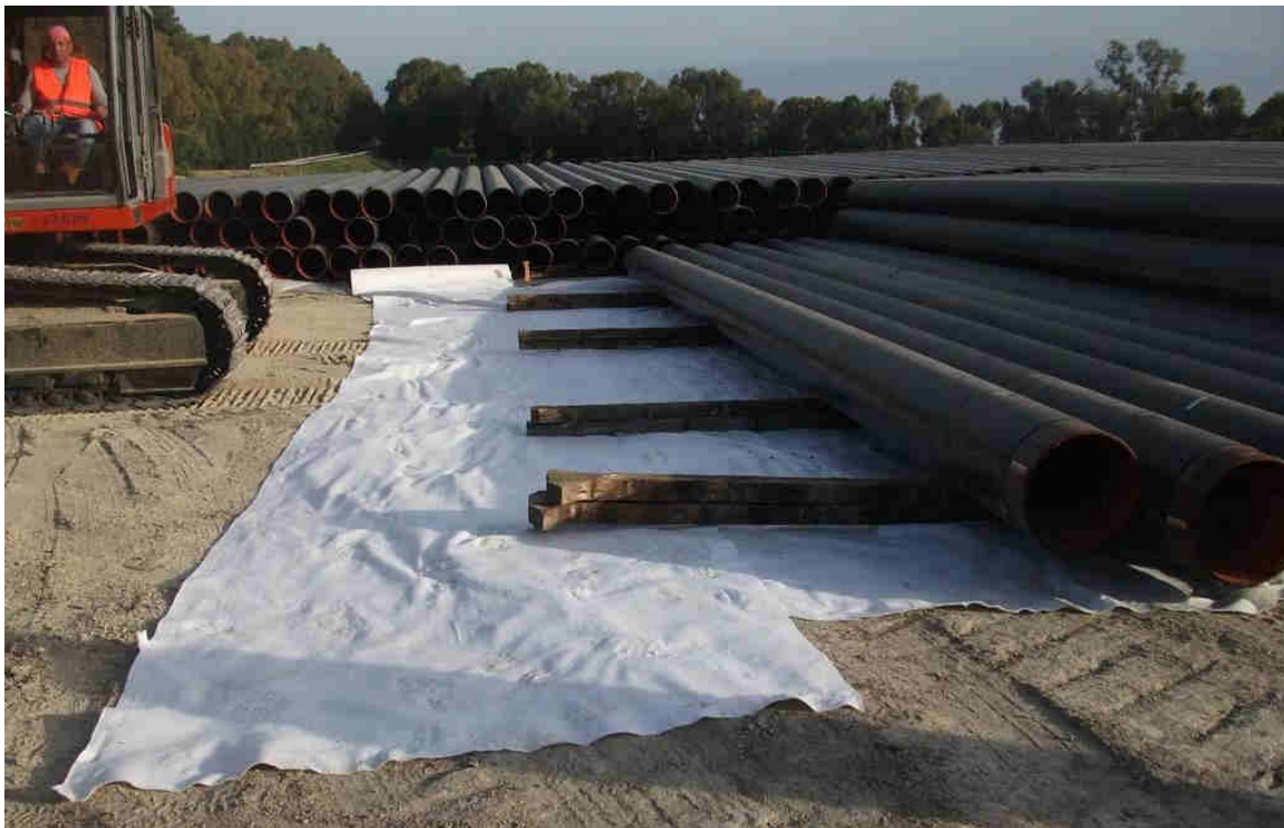
Fig. 10-1 – Esempio di piazzola per l'accatamento tubazioni lungo il cantiere di un gasdotto.
