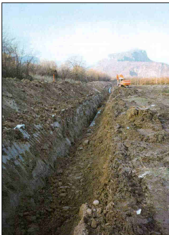
Fig. 2.5 - Operazione di rinterro della condotta
