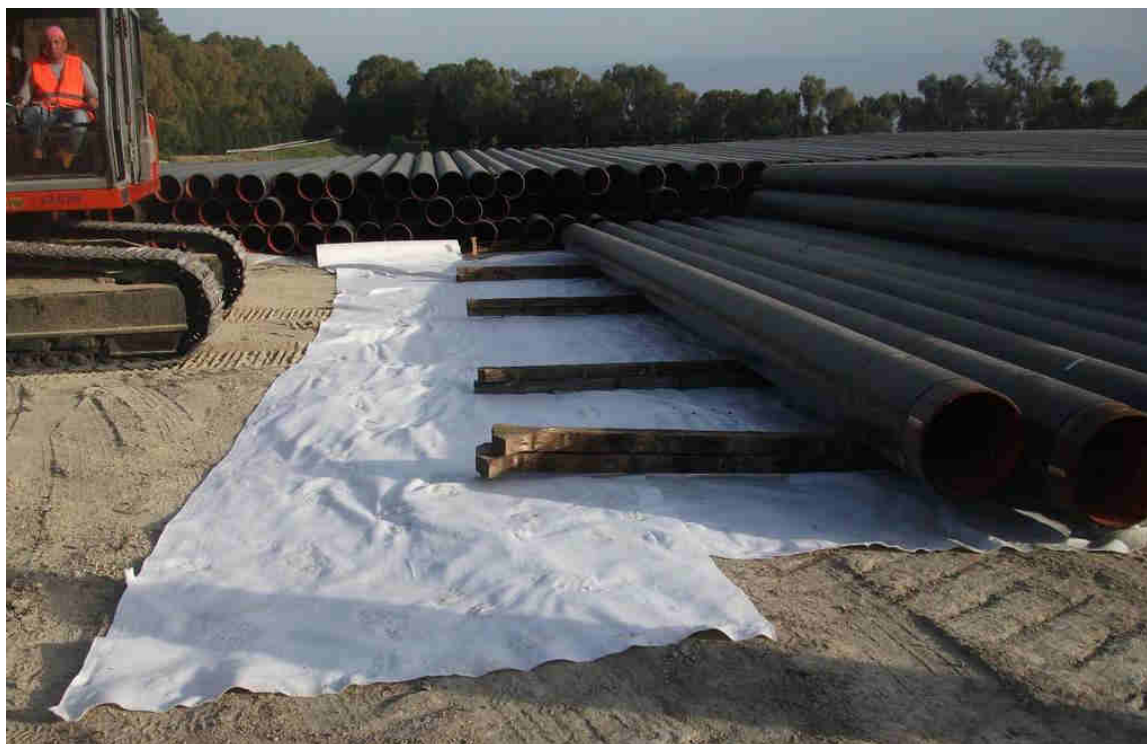
Fig. 2.1 - Piazzola di accatastamento tubazioni
