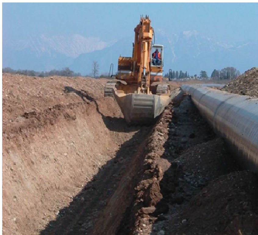
Fig. 2.3 - Scavo per l'alloggiamento della condotta
