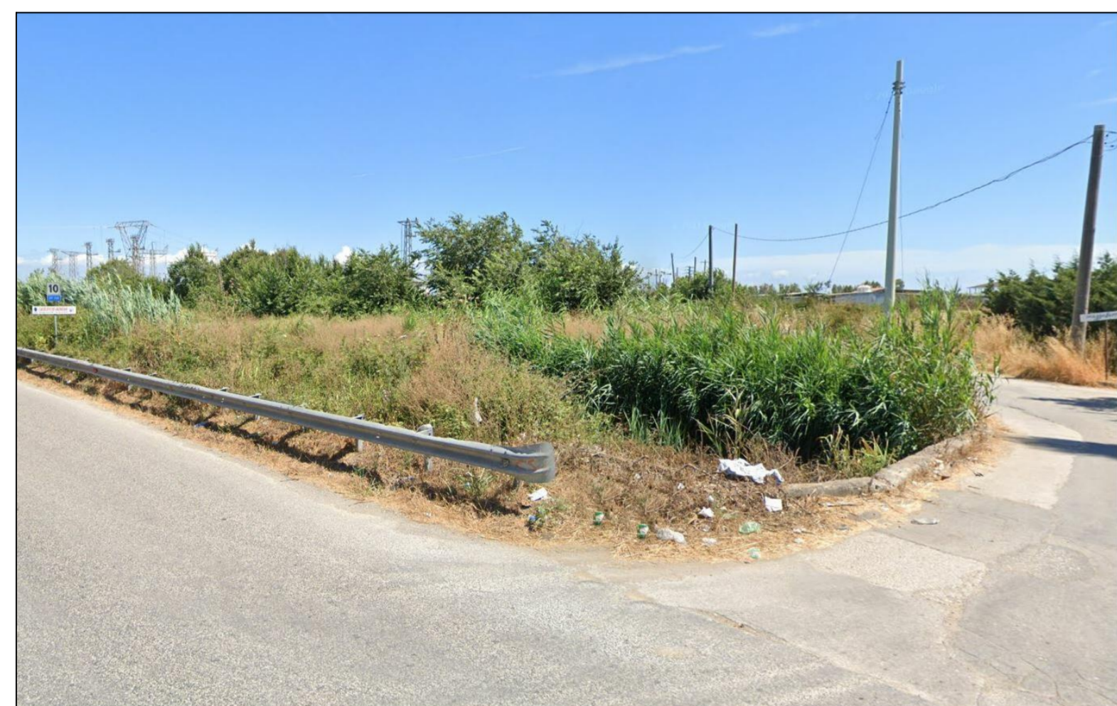
FOTO3 Il sistema della viabilità locale
