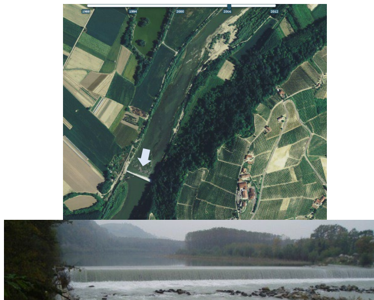
Figura 7 – Condizione della traversa nel 2006
