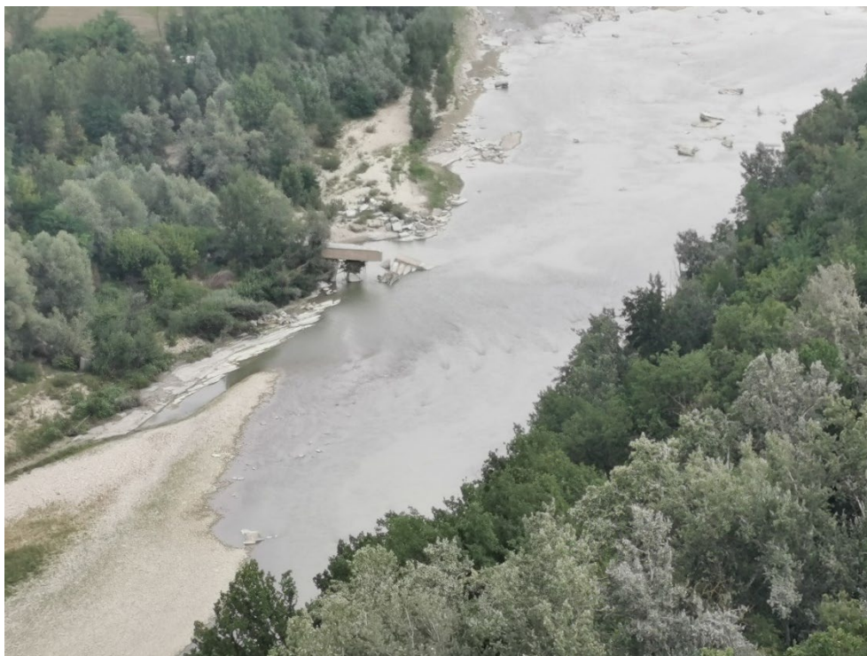
Foto 2 – Dettaglio del relitto della preesistente traversa
