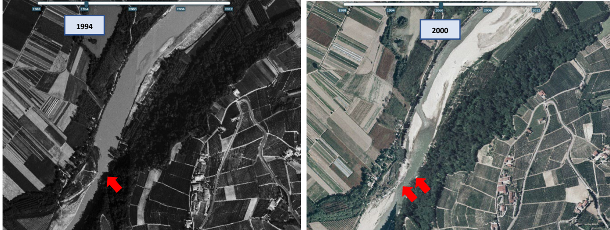
Figura 6 – Processo di compromissione della traversa negli anni 1994 e 2000.
