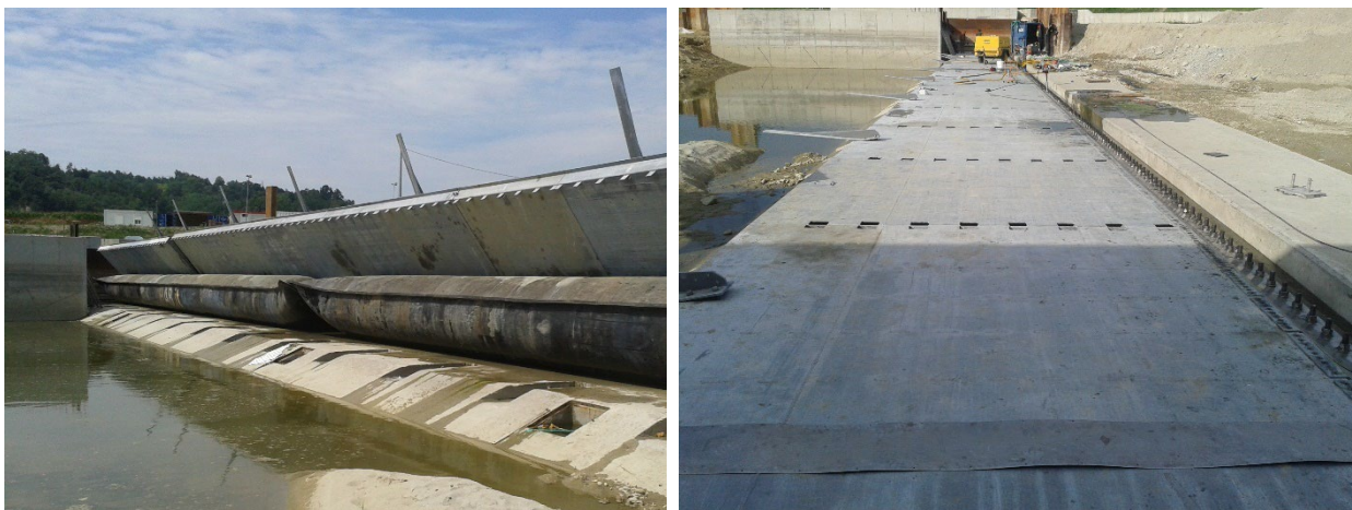
Figura 20 – Sbarramento gonfiabile scudato con singolo elemento elastomerico di gonfiaggio a valle di H=4,2 m e L=85 m analogo a quello previsto in progetto. Fasi di collaudo e gonfiaggio dell'elastomero (in sinistra) e fasi di installazione con sbarramento in posizione completamente abbattuta (in destra)
