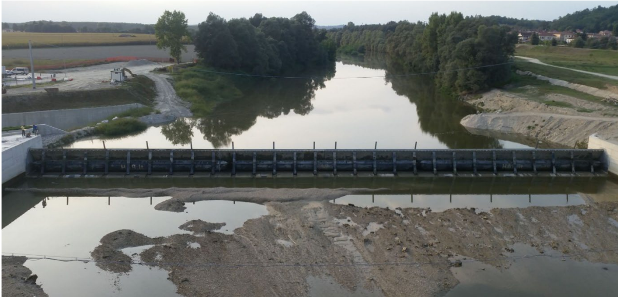
Figura 21 – Sbarramento gonfiabile scudato con singolo elemento elastomerico di gonfiaggio a valle di H=4,2 m e L=85 m analogo a quello previsto in progetto. Fase di innalzamento
