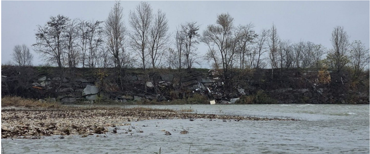
Figura 12 – Difese spondali localizzate in battuta in corrispondenza del meandro in elevato grado di dissesto ed instabilità
