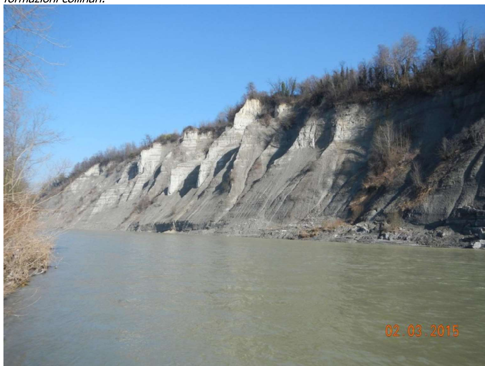
Figura 9: tratto 3, ampio run. Si nota la sponda destra idrografica caratterizzata da una scarpata al margine delle formazioni collinari.
