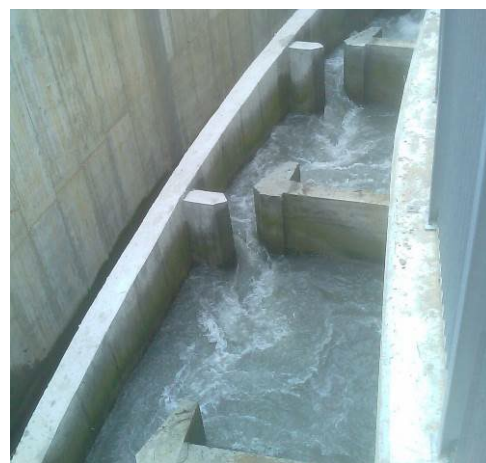
Figura 15 – Passaggio per pesci a bacini successivi di tipo vertical slot
