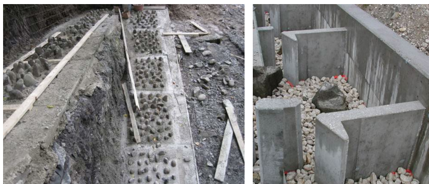
Figura 17 - Esempio di macro-scabrezze di fondo: posa dello strato in un passaggio tecnico a bacini successivi (foto sinistra) e risultato finale in un passaggio vertical slot (foto destra) (Pini Prato 2011 e Wittacker, 2009).
