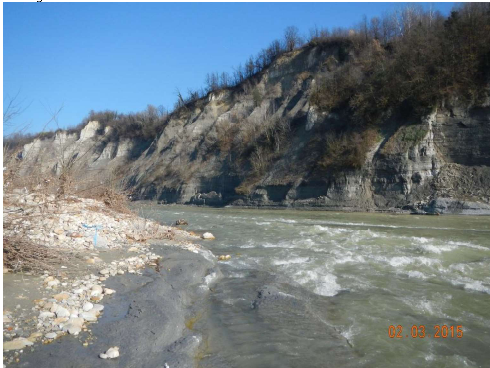
Figura 8: tratto 3, particolare della sponda, in cui è evidente la presenza di argille e la veloce corrente determinata da un restringimento dell'alveo
