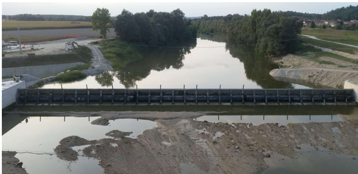
Figura 6 – Sbarramento gonfiabile scudato con singolo elemento elastomerico di gonfiaggio a valle di H=4,2 m e L=85 m analogo a quello previsto in progetto. Fase di innalzamento
