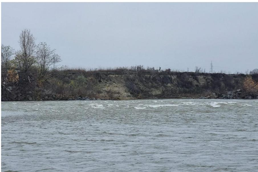
**Figura 55 – Fenomeni di erosione accentuata in corrispondenza della battuta di sponda**
