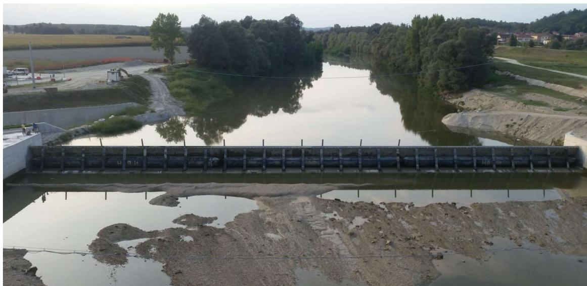
**Figura 7 – Sbarramento gonfiabile scudato con singolo elemento elastomerico di gonfiaggio a valle di  $H=4,2$  m e  $L=85$  m analogo a quello previsto in progetto. Fase di innalzamento**
