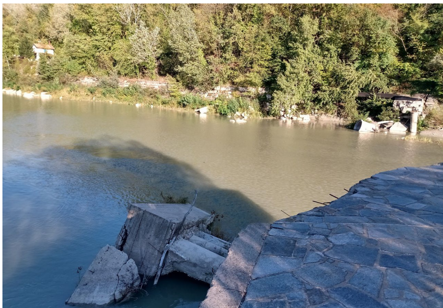
Figura 8 – Derivazione del canale irriguo e l'edificio di guardiania in sponda destra
