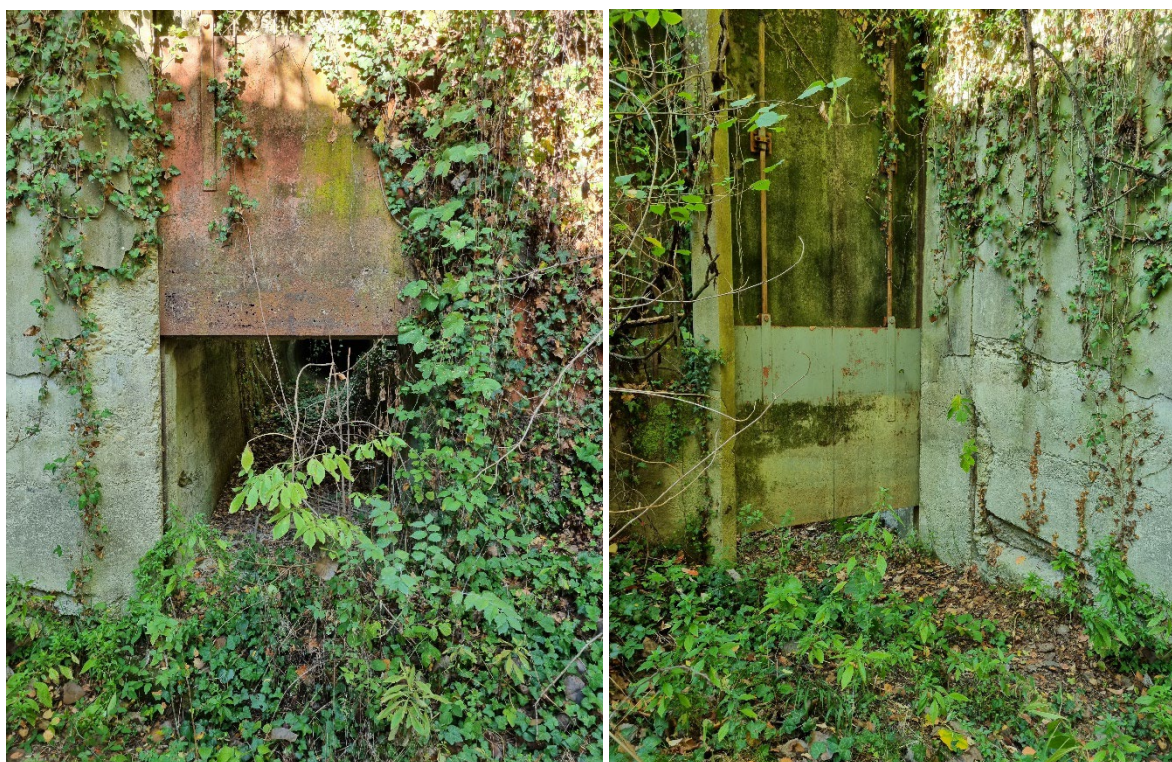
Figura 12 – Organi meccanici di derivazione ubicati in prossimità dell'edificio di guardiania
