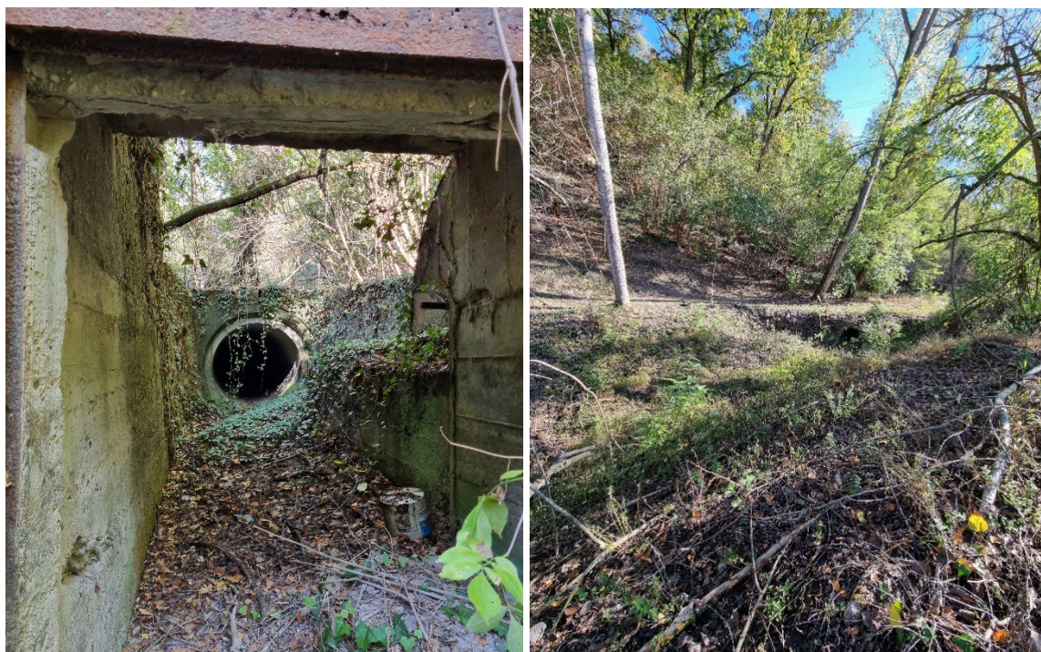
Figura 14 – Ingresso intubato del canale irriguo immediatamente a valle dell'edificio di guardiania e immissione nel canale aperto
