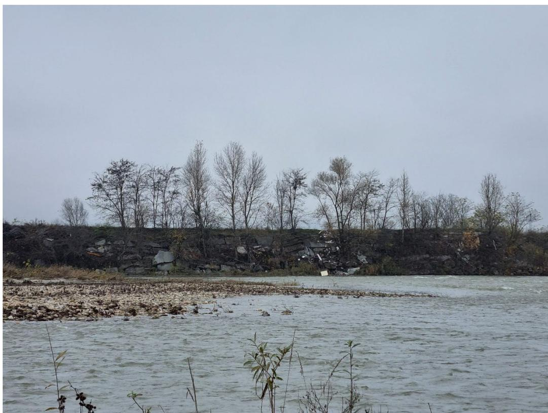
*Figura 14 – Tratto di intervento dove si prevede la realizzazione della scogliera in massi ciclopici: è evidente che si tratta del ripristino di una preesistente difesa.*
