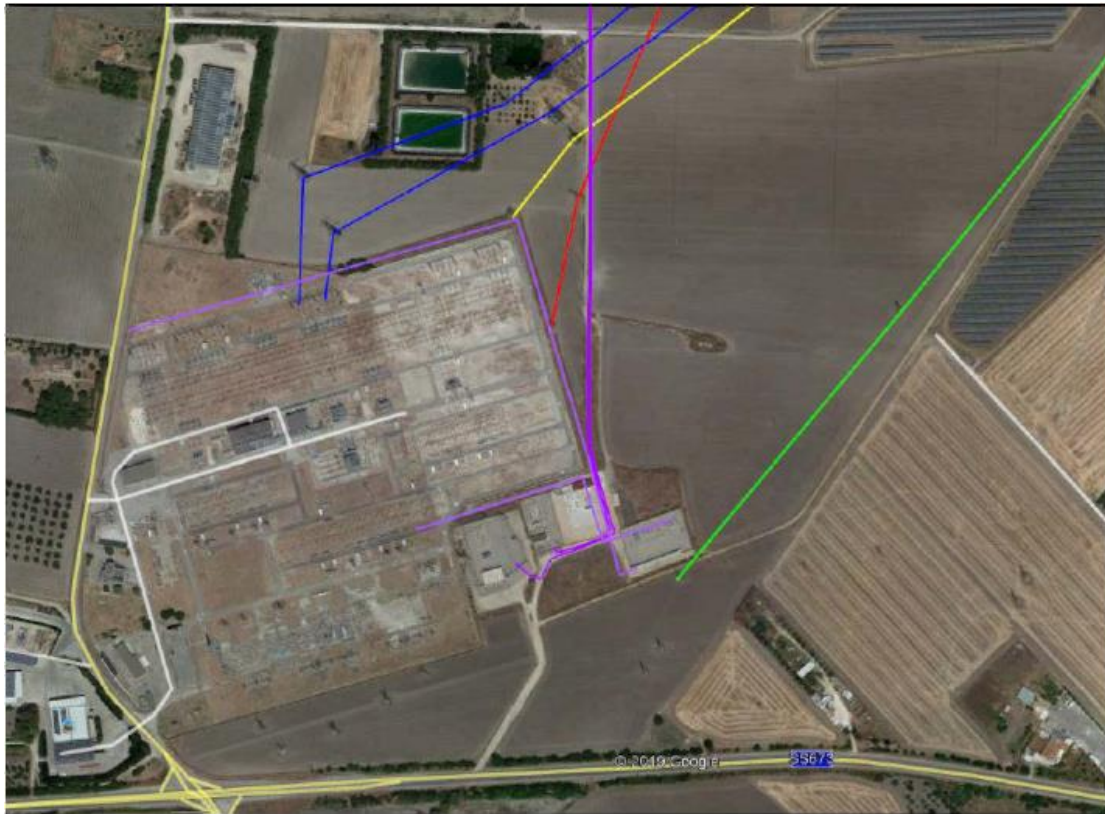
Fig.1 – Ortofoto della SE Foggia-Sprecacenera
