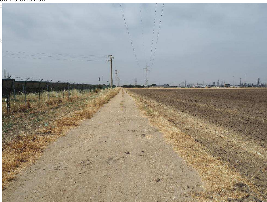
Foto.2.1 – Strada interpoderale vista nord
