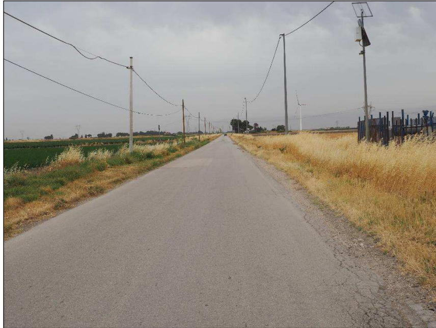
Foto.4.3 – Strada interpoderale vista nord
