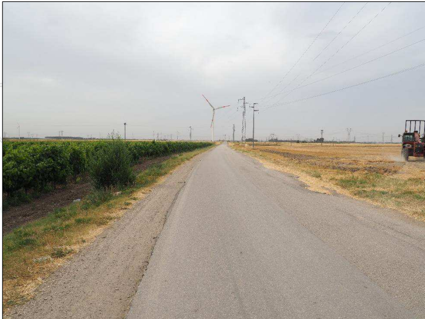
Foto.8.3 – Strada interpodereale vista sud
