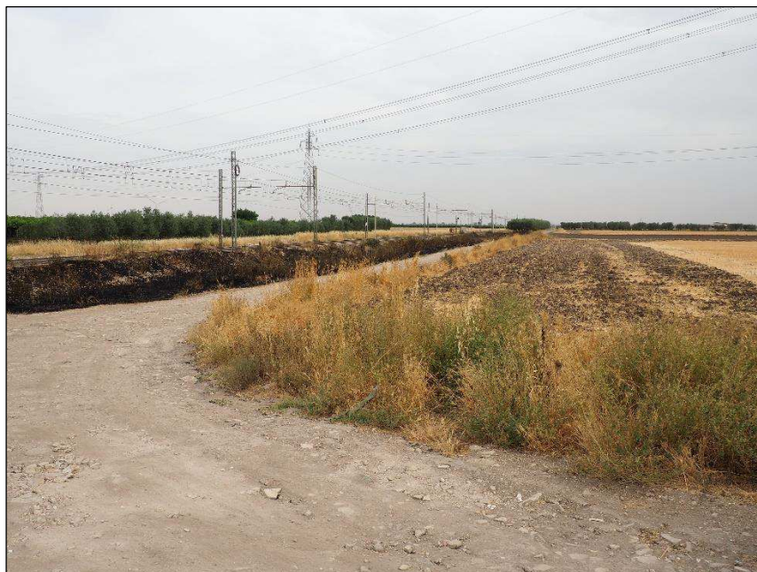
Foto.13.2 – Strada 20 della Bonifica vista nord
