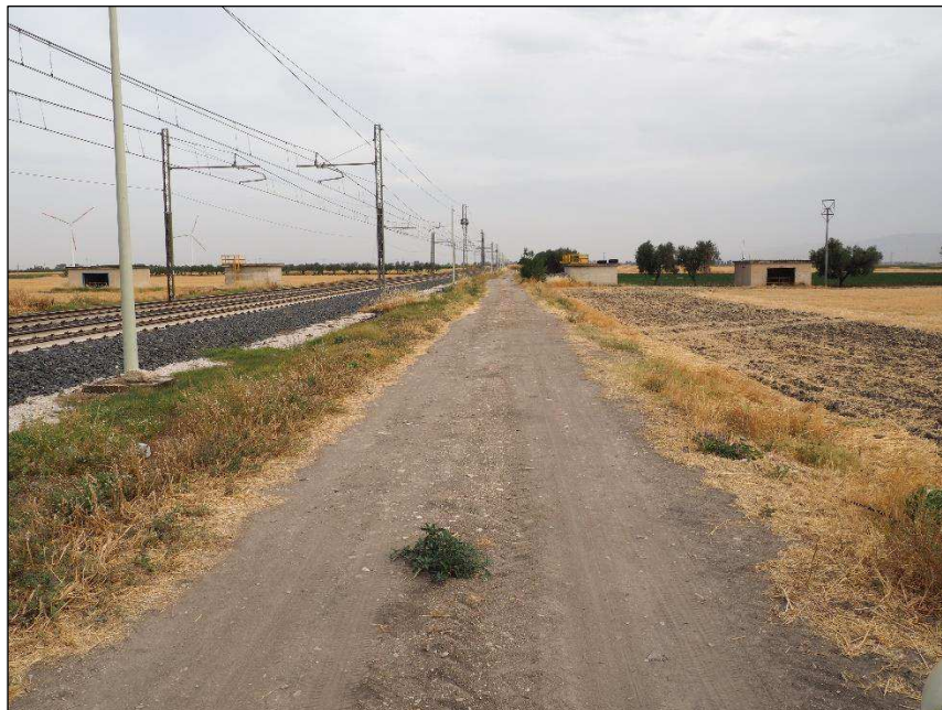
Foto.15.2 – Strada 20 della Bonifica vista nord
