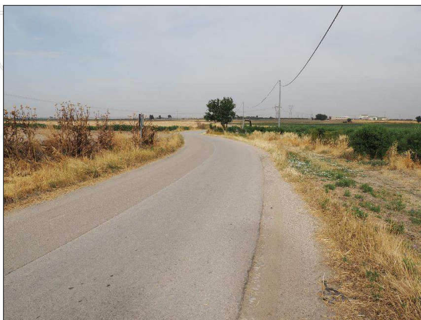
Foto.9.2 – Strada interpoderale vista nord
