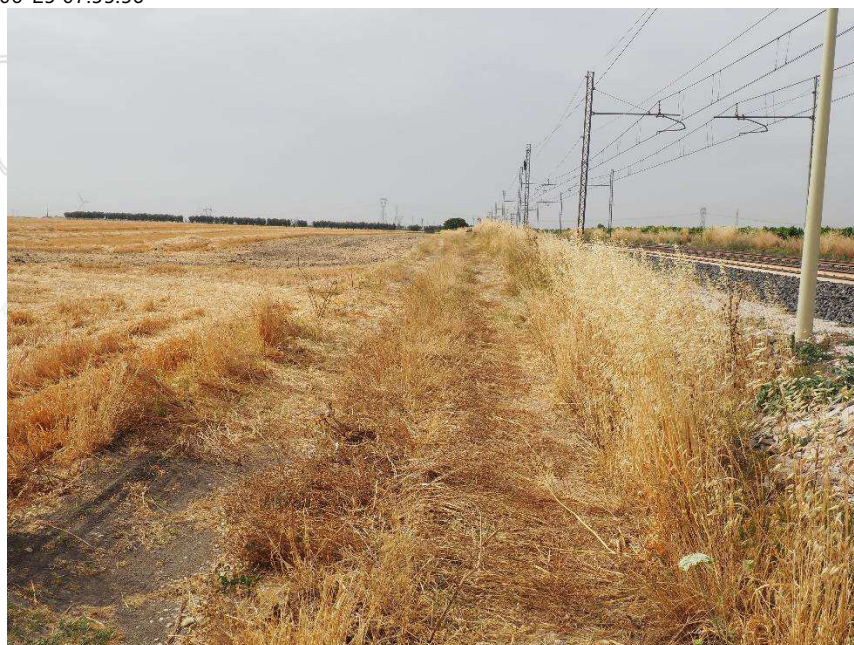
Foto.16.1 – Strada 20 della Bonifica vista nord
