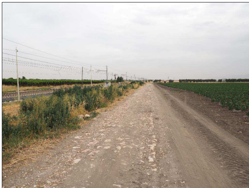
Foto.14.2 – Strada 20 della Bonifica vista nord
