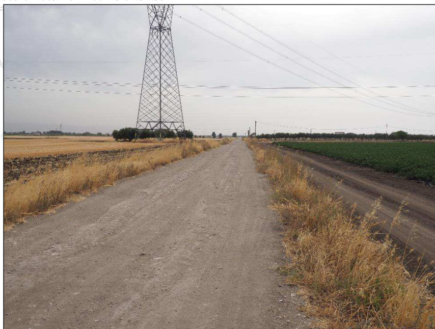
Foto.13.1 – Strada 20 della Bonifica vista sud
