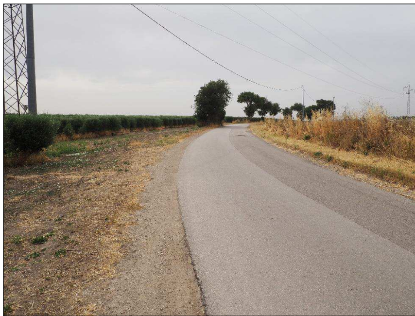
Foto.9.1 – Strada interpoderale vista sud
