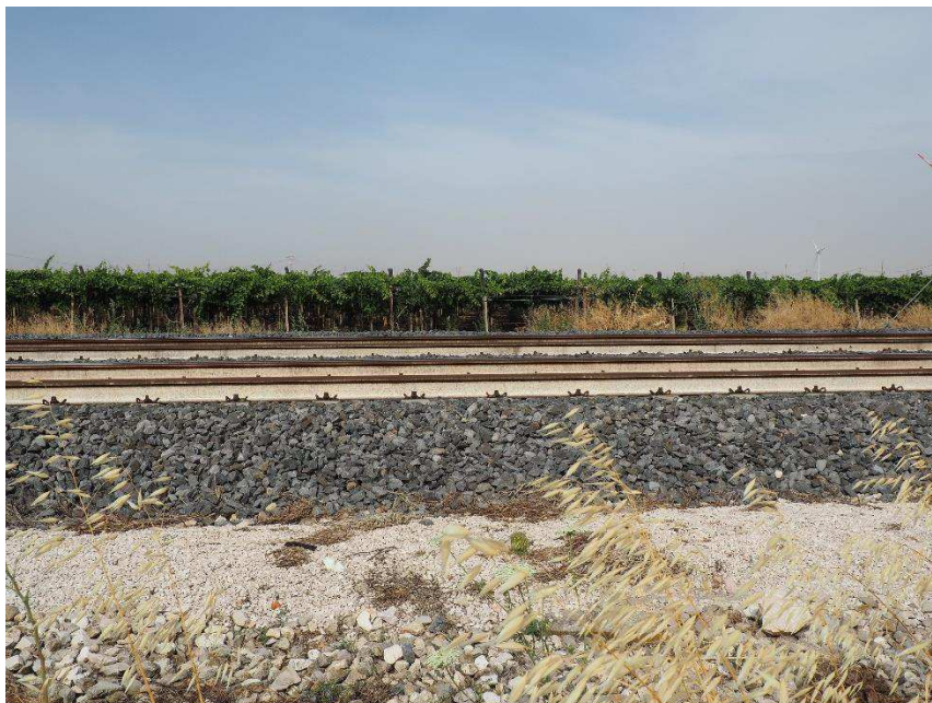
Foto.16.2 – Strada 20 della Bonifica vista est
