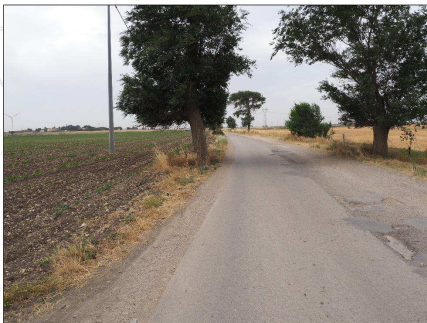
Foto.10.2 – Strada interpoderale vista sud
