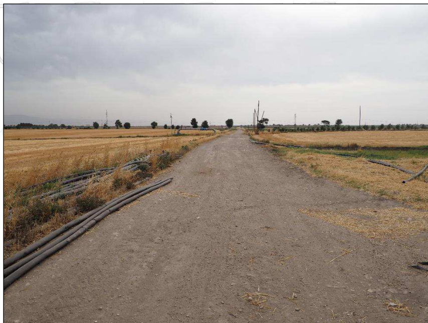
Foto.12.1 – Strada 20 della Bonifica vista est
