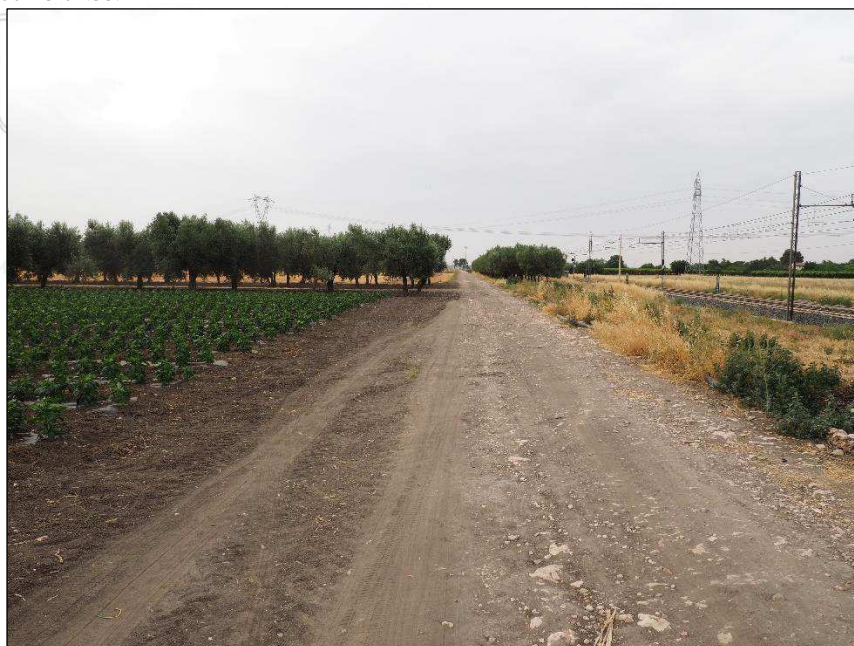
Foto.14.1 – Strada 20 della Bonifica vista sud
