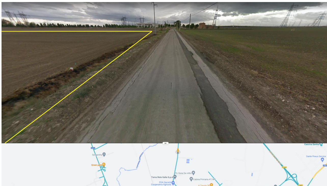
Figura 2-8: Interferenza elettrodotto – Tratturello Foggia - Sannicandro
