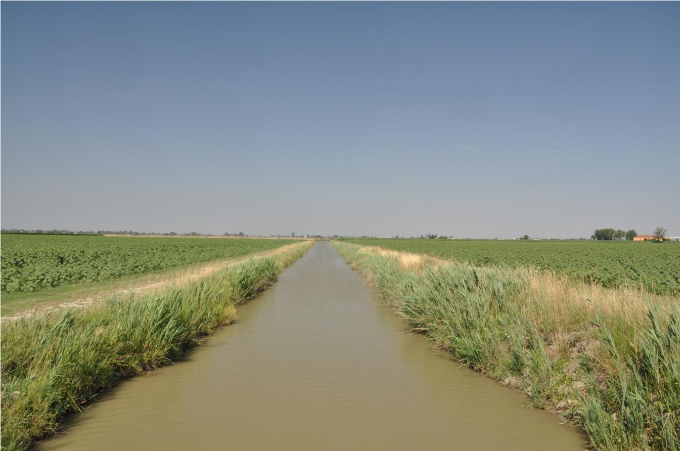
Canale di raccolta delle acque
