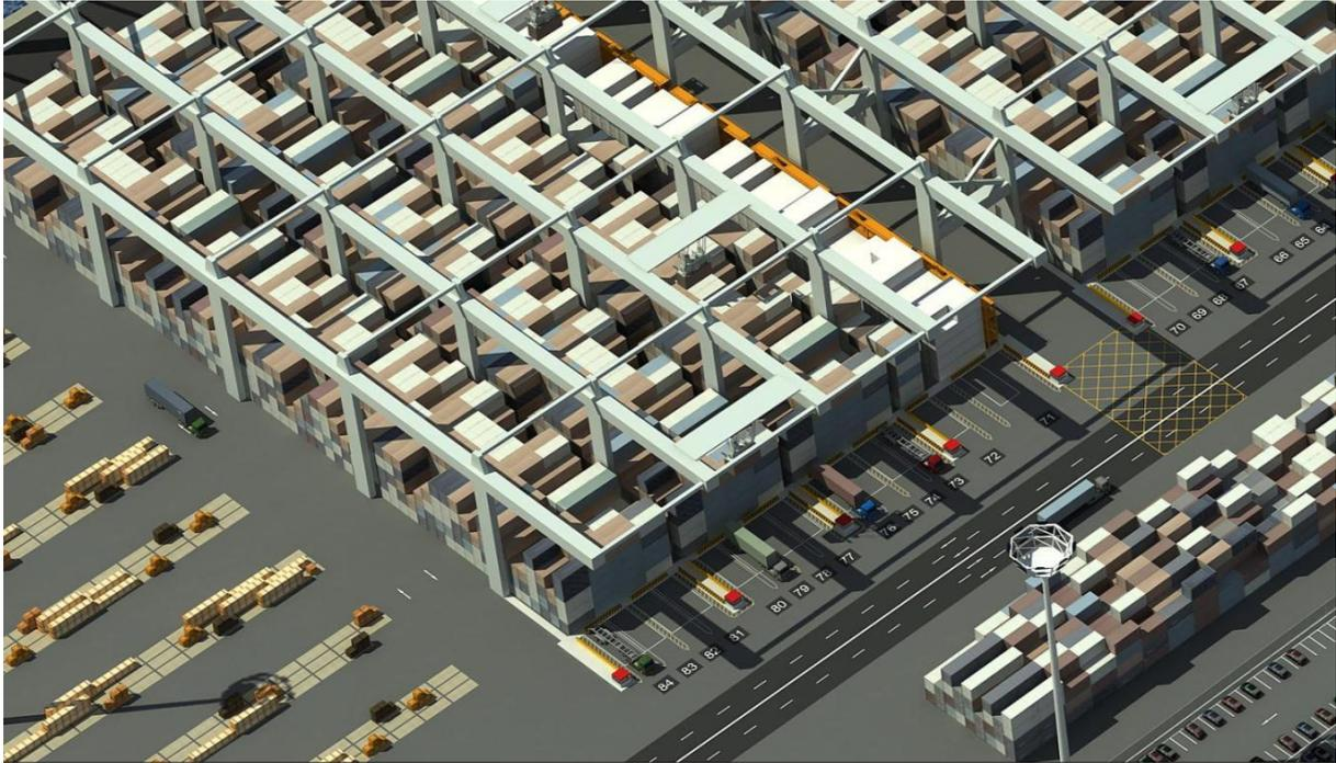
Figura 2-17 – Terminal container ad elevata automazione – rendering esemplificativo vista aree di deposito e prelievo/consegna
