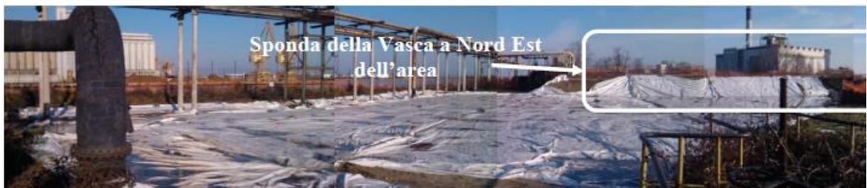
Figura 4-21 – Intervento di scotico Settore 3 - UA1 I° Stralcio - copertura provvisoria (in secondo piano si vede la sponda della vasca che insiste sulla porzione est del poligono di Thiessen nella quale non è stato possibile procedere con l'attività di scotico)
