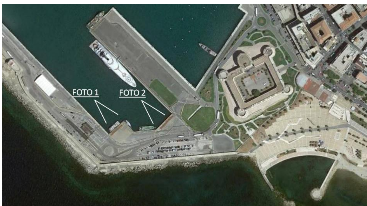
Figura 12 - Strutture di attracco da demolire sulla banchina Marconi
