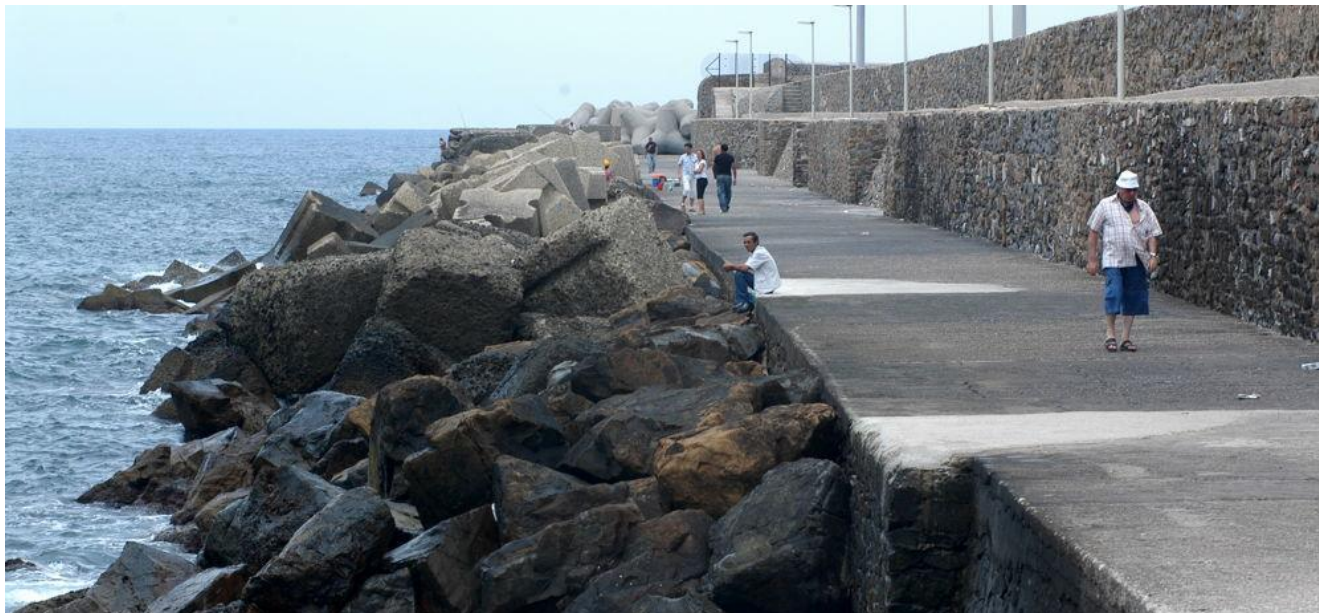
Figura 7 – Foto dell’antemurale Traiano in corrispondenza della banchina Marconi
