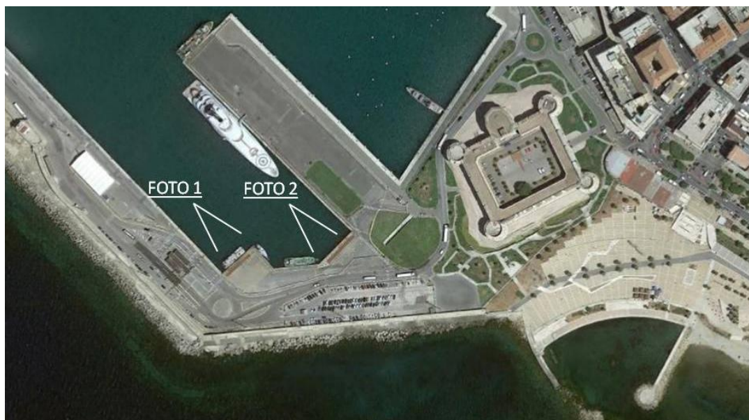
Figura 8 - Strutture di attracco da demolire sulla banchina Marconi
