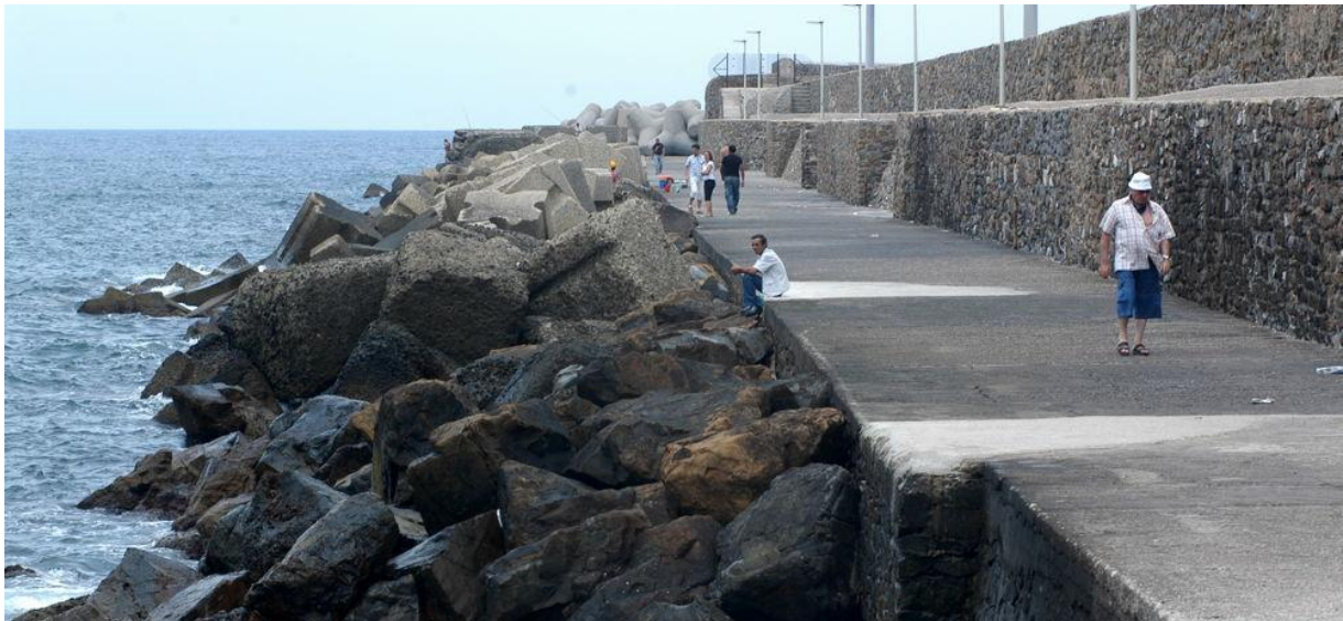
Figura 9 – Foto dell'antemurale Traiano in corrispondenza della banchina Marconi
