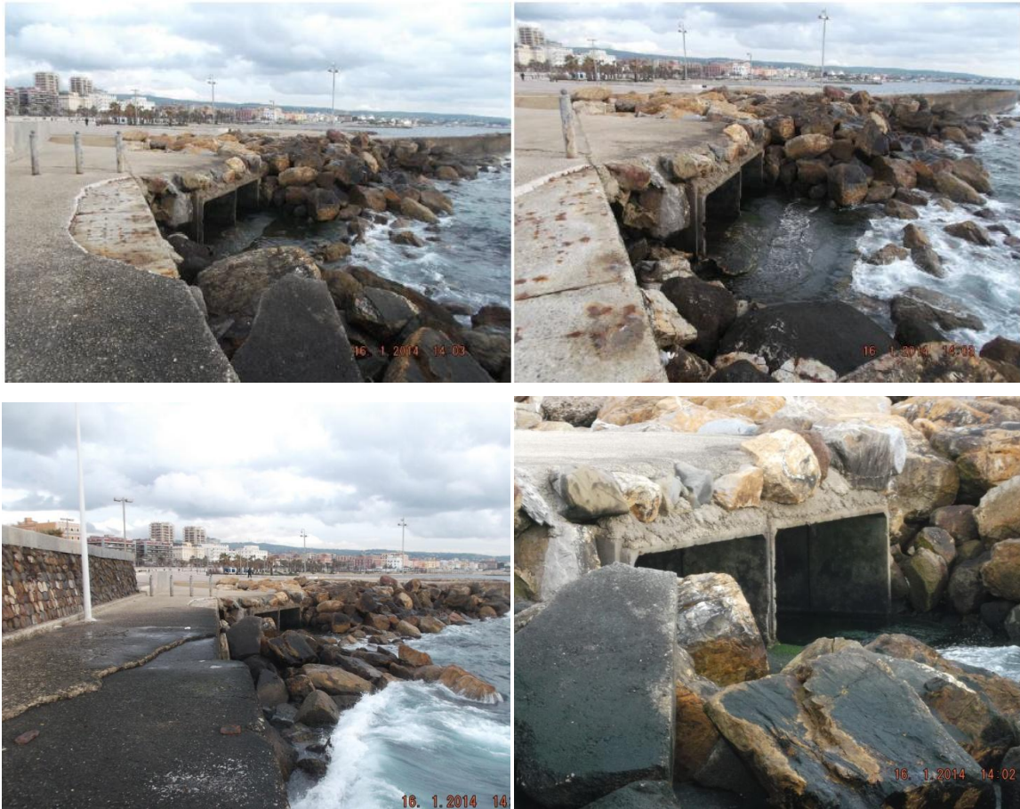
Figura 9 - Scarico a mare
