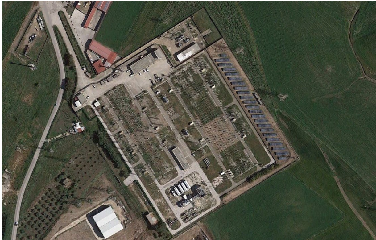
Figura 35 – Immagine della SE 220 kV Favara di Terna.
