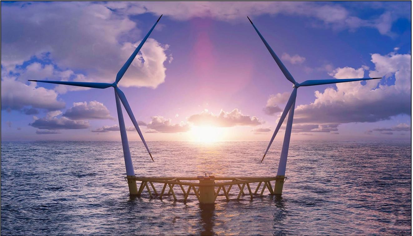
Figura 4: Struttura di fondazione galleggiante con doppio aerogeneratore.
