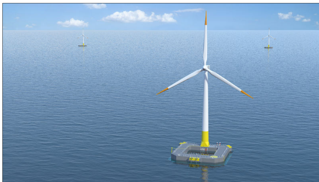
Figura 2.5: Turbina eolica offshore di tipo Barge
