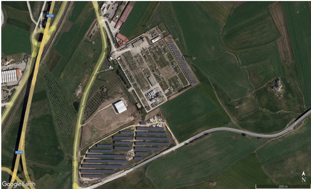
Figura 4 – Immagine dell’attuale SE 220 kV “Favara” di Terna.
