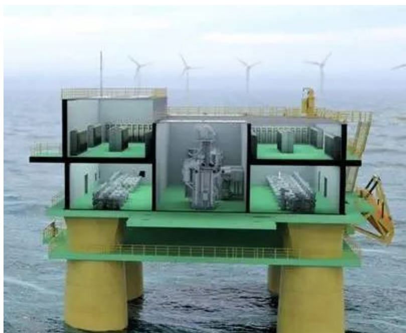
Figure 9/10/11 – Esempio di Stazione HVDC di trasformazione 150/500 kV.
