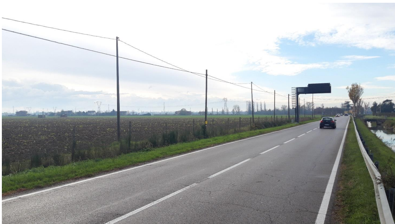
Strada Provinciale n. 2 ripresa da punto "A"
