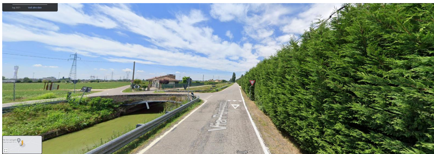
Foto 6. Tracciato del Canale Naviglio in primo piano: il particolare del ponte di attraversamento del canale Loc. Pontegradella collocato poco a valle dell'attraversamento in "subalveo" del tracciato del cavidotto elettrico interrato di connessione alla rete (realizzazione mediante "trivellazione orizzontale controllata" – TOC).
