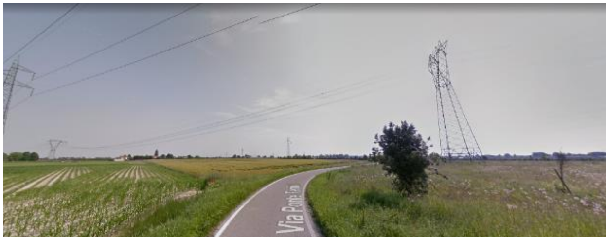
Figura 32 – Foto 5: particolare contesto, asse viario interessato dal tracciato interrato del cavidotto di connessione alla rete
