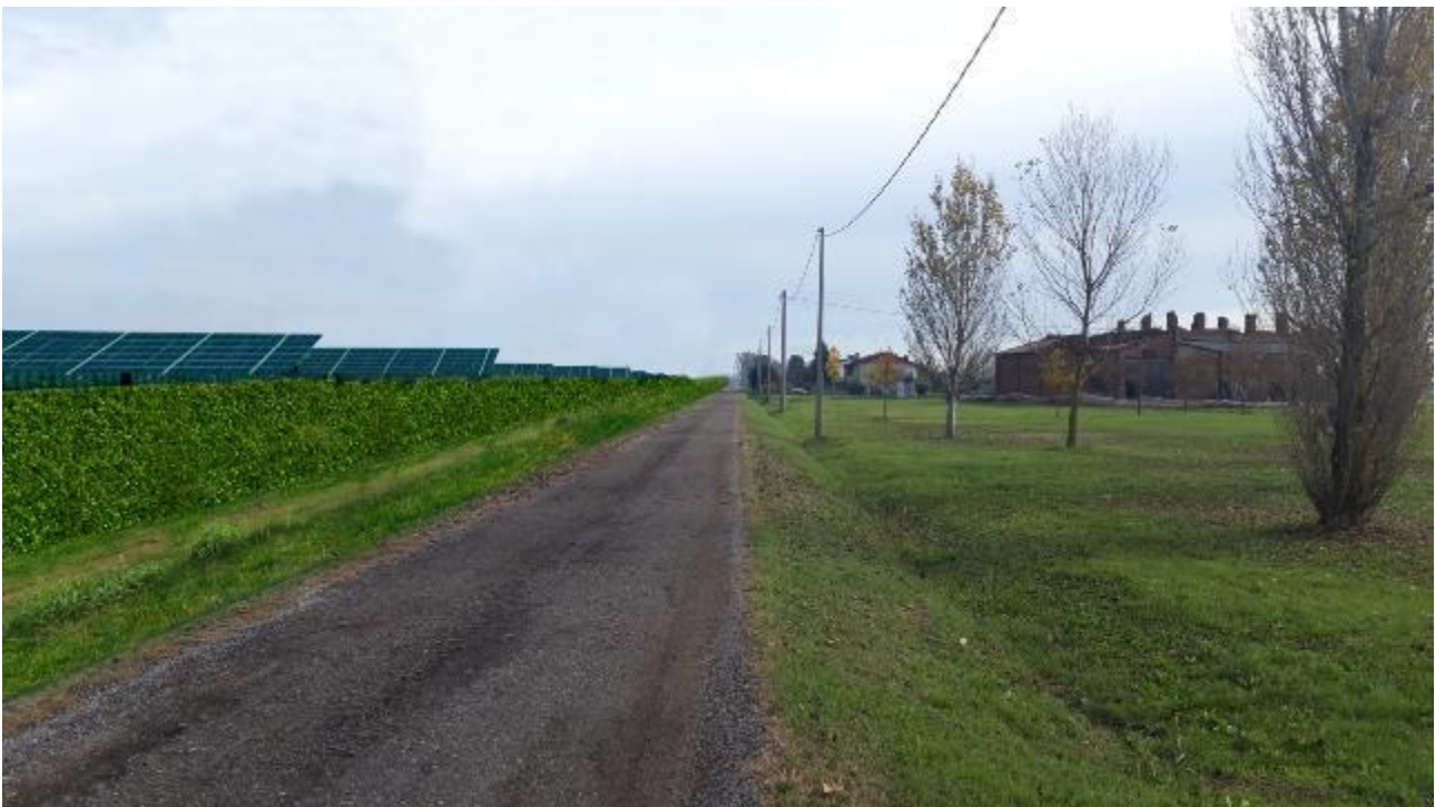
Figura 41 - Particolare contesto agricolo circostante le aree di impianto ad opere di impianto realizzate - rendering fotografico che evidenzia due situazioni comuni di configurazione del generatore fotovoltaico nel corso del funzionamento quotidiano dell'impianto: "tilt" dei moduli da orizzontale a circa 55° rispetto all'orizzontale (massima altezza dal suolo dei moduli - circa 4 m) e la siepe in essenze locali per la mitigazione ambientale prevista al confine delle proprietà di intervento. L'immagine è nei pressi di un'attuale asse viario a carattere locale (punto di ripresa corrispondente a "Foto11" precedente rappresentativa come riferimento per il contesto paesaggistico locale in condizione attuale, precedente all'intervento).
