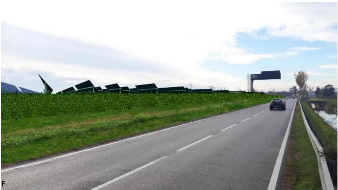
Figura 40 - Particolare contesto ad opere realizzate - rendering fotografico che evidenzia due situazioni comuni di configurazione del generatore fotovoltaico nel corso del funzionamento quotidiano dell'impianto: "tilt" dei moduli da orizzontale a circa 55° rispetto all'orizzontale (massima altezza dal suolo dei moduli - circa 4 m) e la siepe in essenze locali per la mitigazione ambientale prevista al confine delle proprietà di intervento; sulla destra il Canale "Fosso Val D'Albero" oggetto della tutela D.lgs 42/2004. Art. 142, lett. C. Il nuovo layout progettuale prevede l'arretramento del campo agrivoltaico, e di conseguenza dei moduli, oltre la fascia di rispetto dei 150 prevista dal bene tutelato. I moduli, saranno pertanto meno visibili rispetto i fotoinserti qui riportati.
