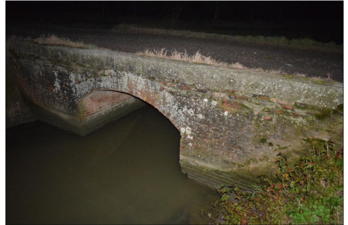
UT 8, vista da SE.
