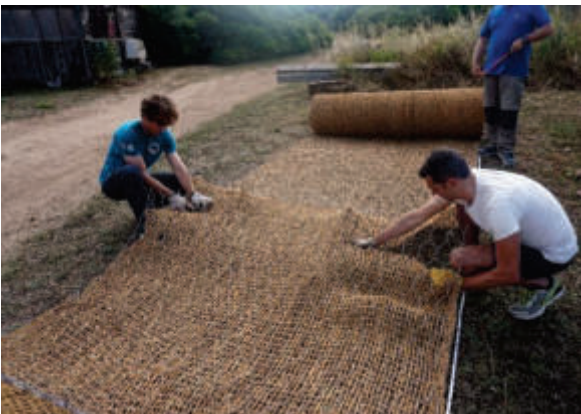
Fig. 67- Preparazione delle geostuoie prima della posa (Corsica).
