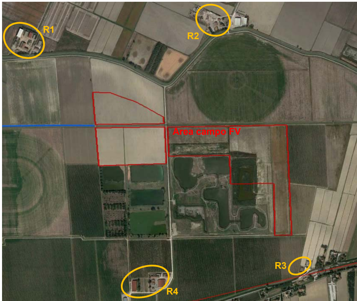
Figura 3 – Foto aerea dell'area in esame con individuazione dei ricettori presso il campo FV
