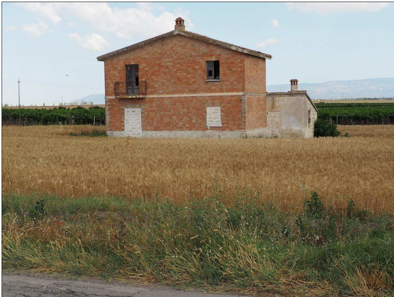
Figura 7 - Fabbricati rurali diruti
