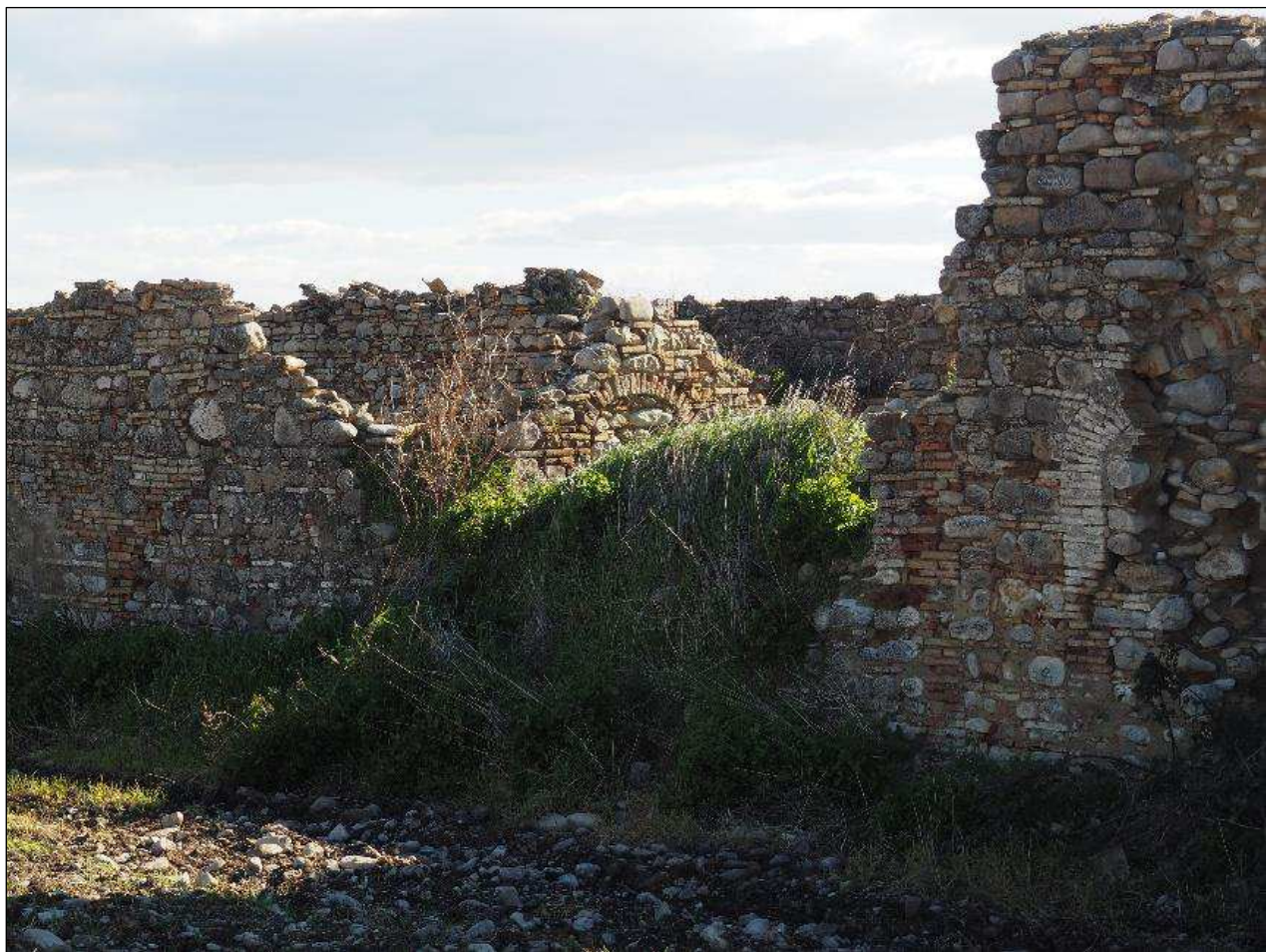
Figura 1- Un esempio tipico di casa in delle campagne pugliesi
