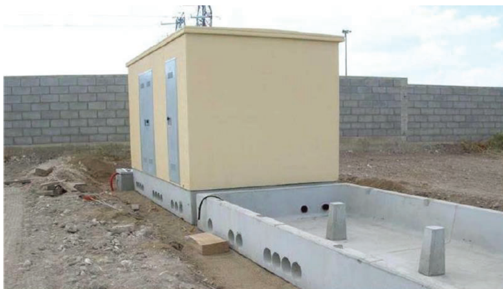
Figura 6: Cabine elettriche
