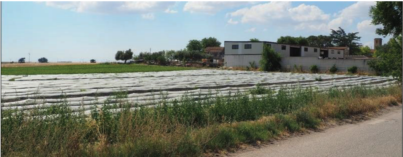
Figura 5: Centro aziendale di conferimento
