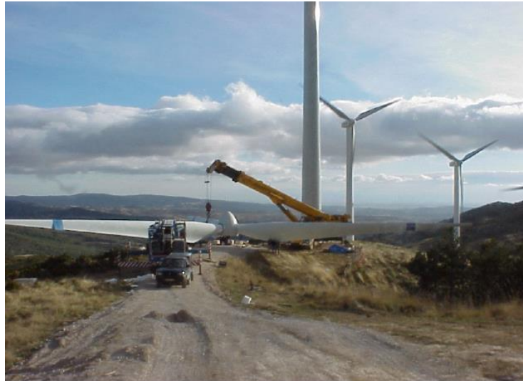
Figura 2-3: Ingombro del rotore a terra
