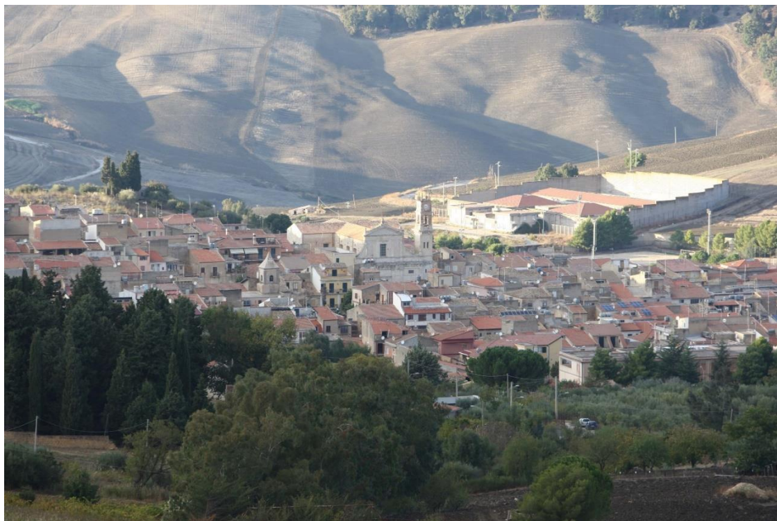
Figura 4-15: veduta dell'abitato di Villalba
