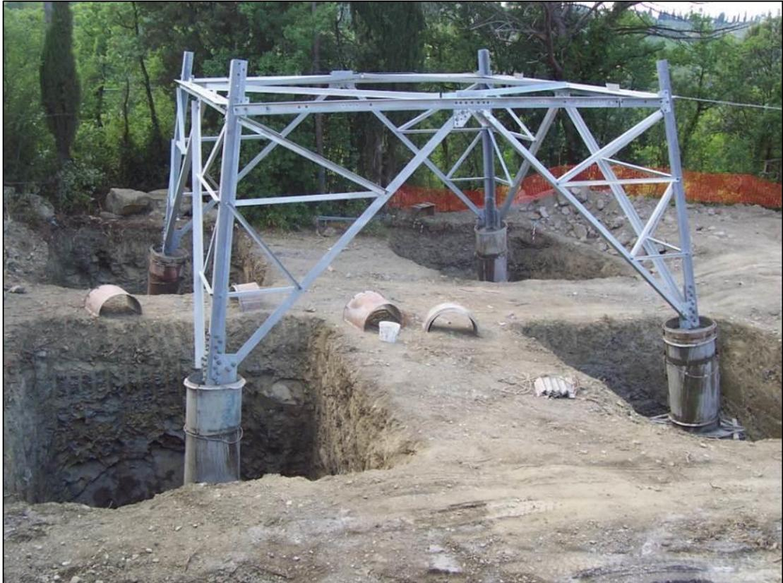
*Fig. 3.5 – Esempio di fondazione di un sostegno a traliccio*
