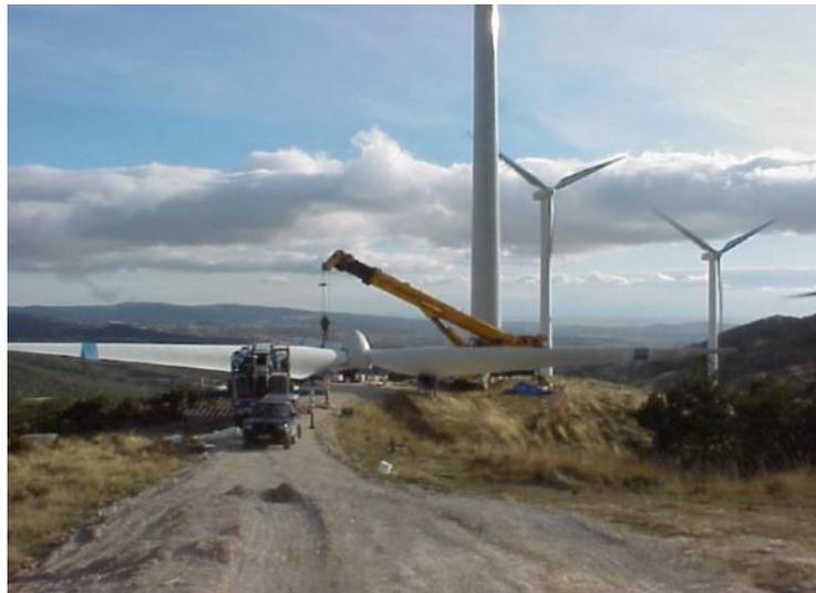
**Figura 3-3: Ingombro del rotore a terra**
