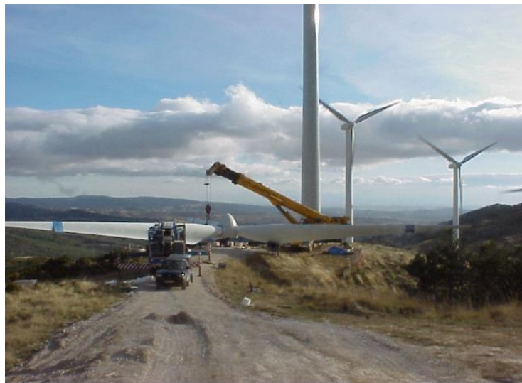
Figura 3-4: Ingombro del rotore a terra
