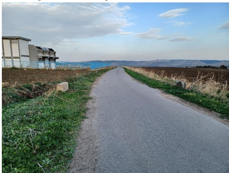
Figura 19 – Tratto di sede stradale dove ricade il cavidotto in MT
