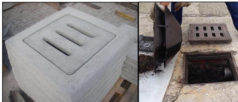
**Figura 5. 2 Pozzetti di grigliatura**
