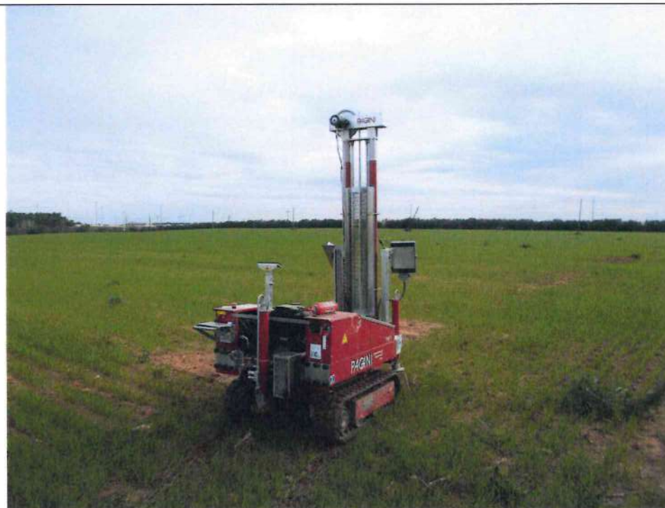
Esecuzione prova DPSH 6
