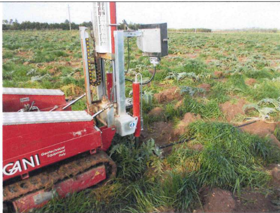
Esecuzione prova DPSH 4
