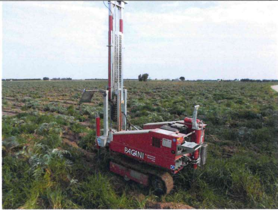
Esecuzione prova DPSH 3
