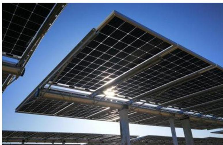
Figura 2.5: Particolare strutture tipo trackers di sostegno moduli
