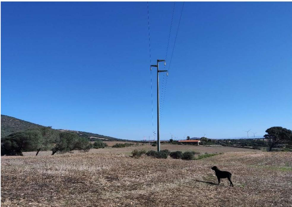
Figura 2.2: Linea aerea di media tensione MT\_A01.
