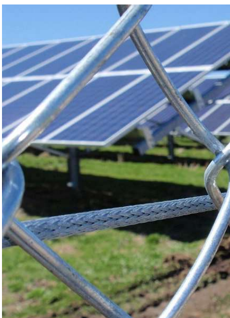
Figura 4.12 - Cavo in fibra ottica montato su rete metallica.
