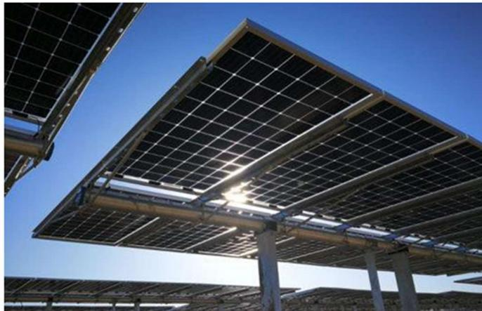
*Figura 2.3: Particolare strutture di sostegno moduli*
