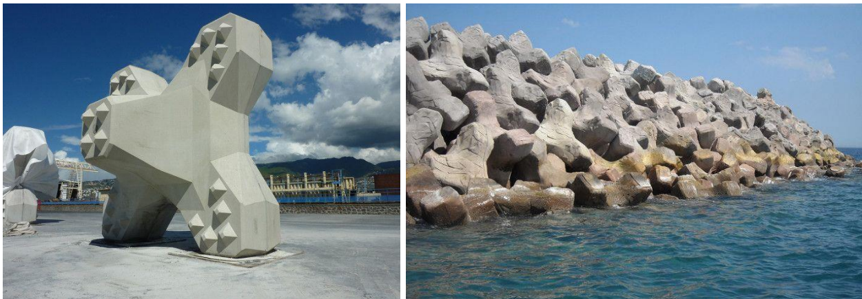
Figura 7-1: Mantellata single-layer in massi artificiali tipo Ecopode™ (dx, parti emerse) e tipo Accropode™ (sx, parti sommerse)
