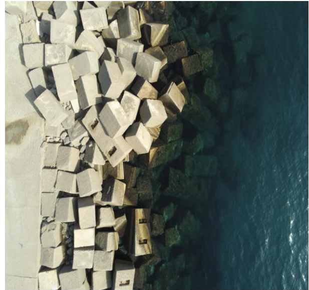
Figura 6-4: Attuale mantellata del porto dell'Arenella in massi in cls parallelepipedi
