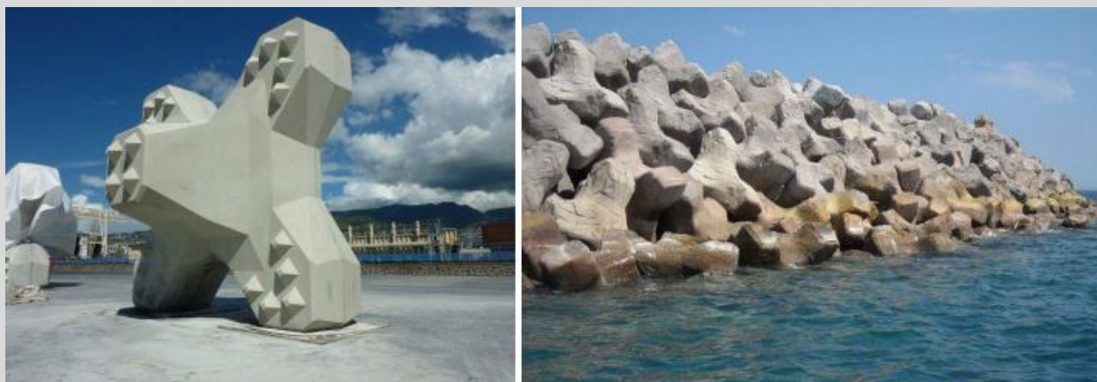
Figura 2.7 - Mantellata single-layer in massi artificiali tipo Ecopode™ (dx, parti emerse) e tipo Accropode™ (sx, parti sommerse).
