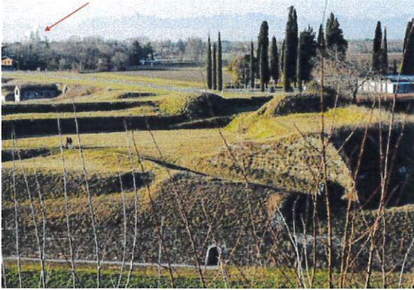
Figura 17 A titolo esemplificativo si riporta il Punto di scatto n°4 Anello del Rivellino all'altezza del cimitero di Palmanova. - L'areale di studio non risulta visibile mentre, in alto a sinistra risultano visibili le ciminiere dello stabilimento Bipan localizzato a confine con l'area d'intervento (per una ricostruzione delle fotosimulazioni da tutti i punti di scatto proposti a valle dello studio di intervisibilità cfr Elaborato Integrazioni alla Richiesta del MIC|MIC_SS-PNRR del 05/08/2022 prot. 0002224-P)
