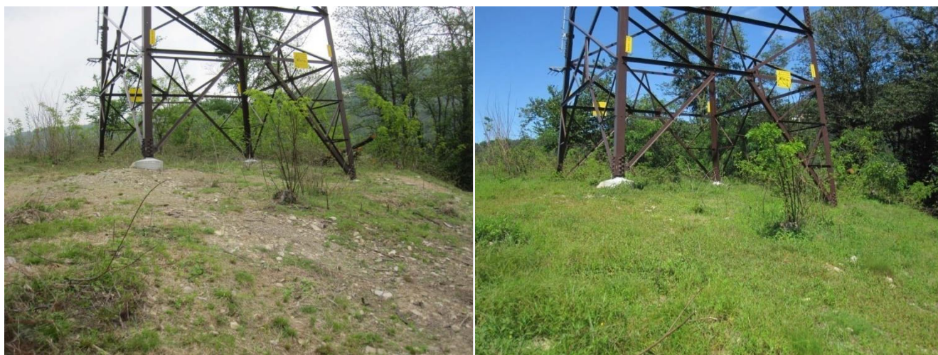
Figura 8-6 Interventi di rinaturazione ante e post operam sulle linee 132 kV della Val D'Ossola Sud
