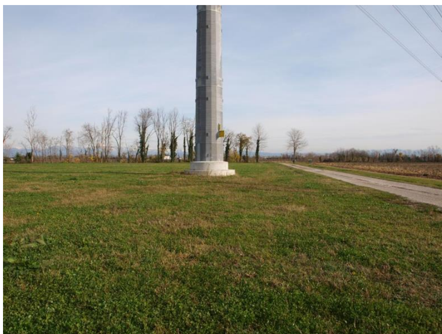
Figura 8-3 Intervento di ripristino ante-operam a prato sulla linea 380 kV Udine Ovest-Udine Sud
